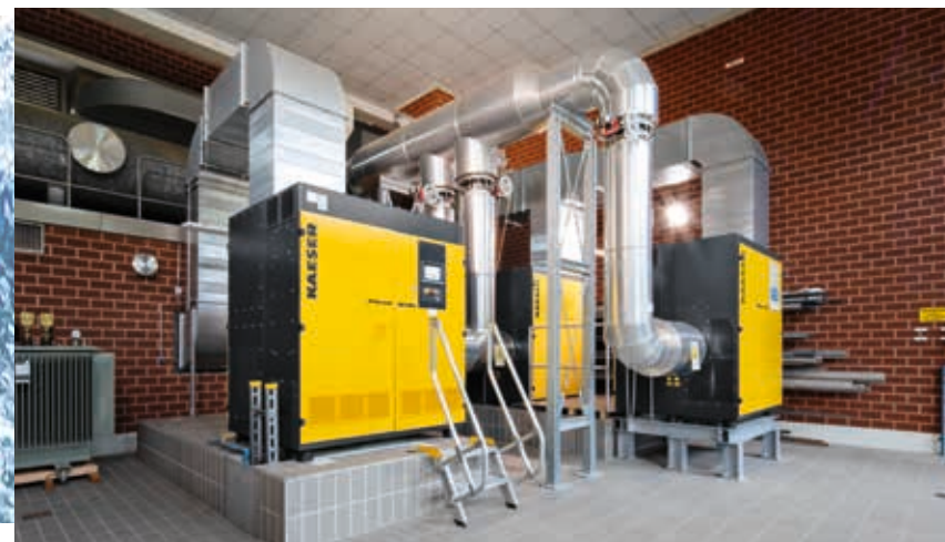
De nieuwe MP 6000-turboblowers zijn de eerste keuze voor het benodigde prestatiebereik.
